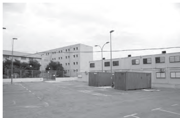
Estado actual del IES Azorín y las aulas prefabricadas
