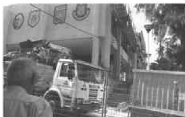
Estado actual de la fachada con el vallado de protección y los andamios
