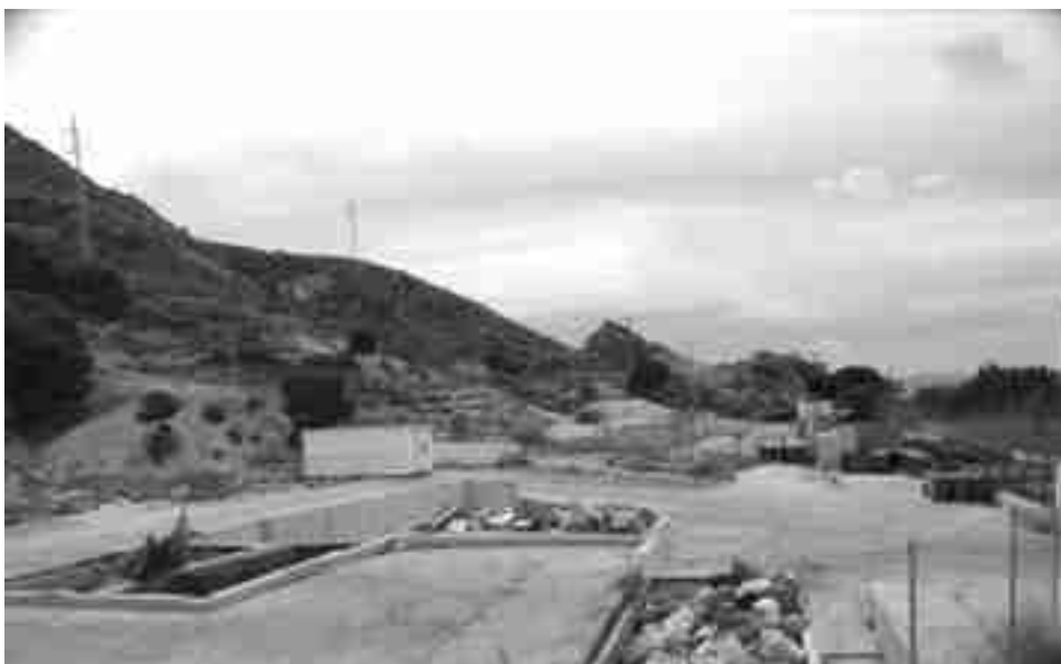
Zona del Ecoparque de Cuatrovientos en donde se encuentran los contenedores de inertes
