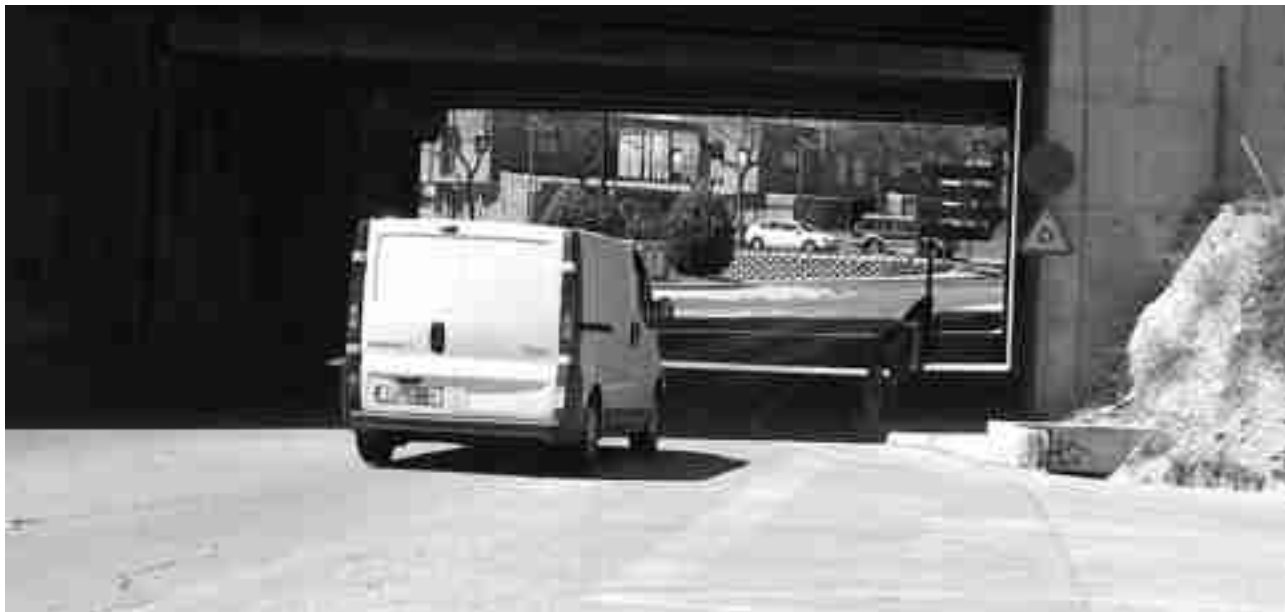
Puente de Salinetas en el que se ha proyectado mejorar el paso peatonal
