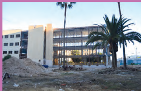
POLÉMICA PP-GOBIERNO POR LAS OBRAS DEL AZORÍN
