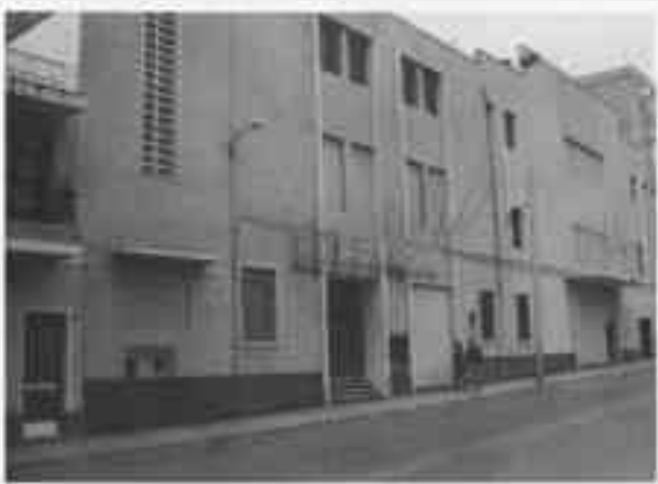
Mercadona quería instalarse en el antiguo "Cine Aguado".
