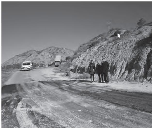
Una técnico municipal, Fermín García y Pascual Díaz visitando las obras
