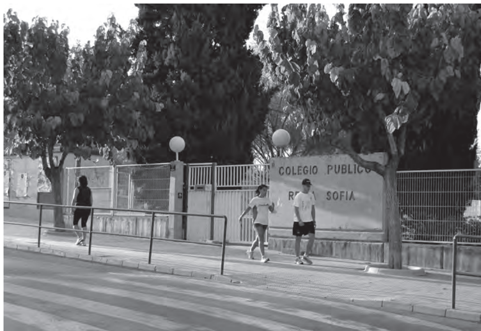
Puerta principal del colegio Reina Sofia en la que se han llevado a cabo algunos trabajos de mantenimiento
