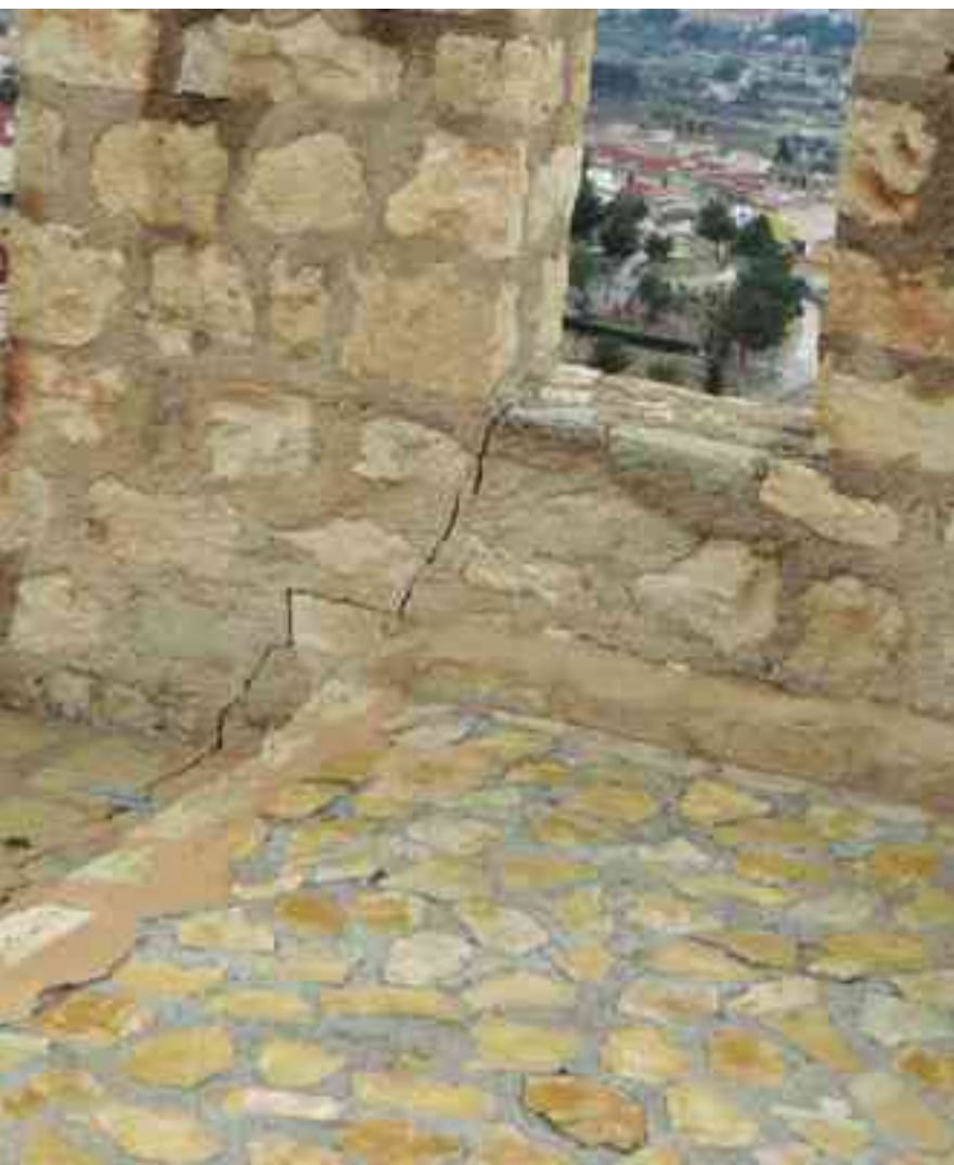
Diferentes detalles de la grieta que recorre las murallas y el suelo del castillo
