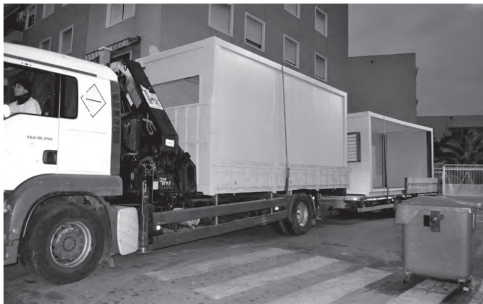
Las aulas prefabricadas se están descargando en la parcela que se ha adecuado para su instalación
