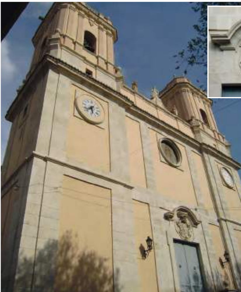
Fachada de la iglesia de San Bartolomé, Apóstol
