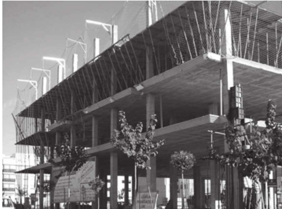
Viviendas de VPO en construcción, en la avenida Hispanoamérica
