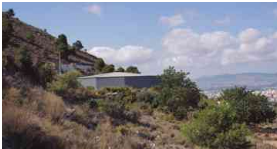
Depósitos de agua de Aiguarrius
