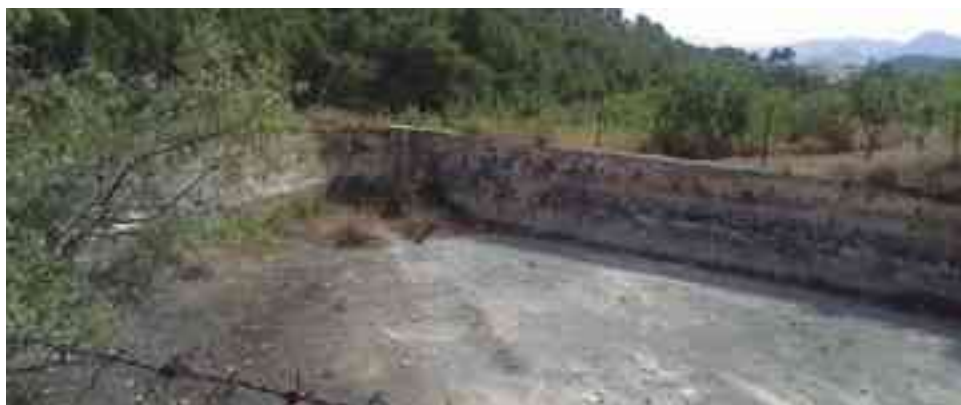
Antigua balsa de riego que ahora se quiere rehabilitar
