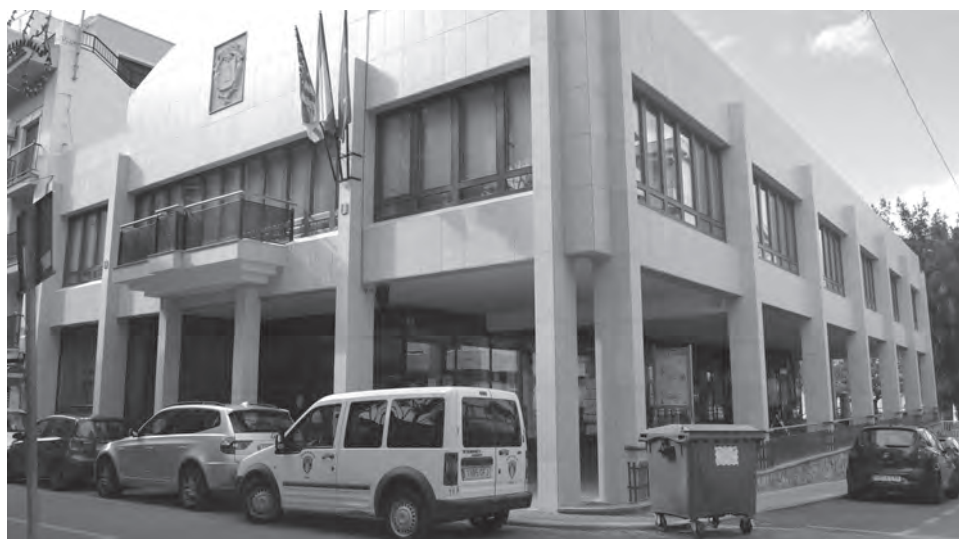
Imagen reciente de la fachada exterior del Ayuntamiento tras la reciente remodelación
