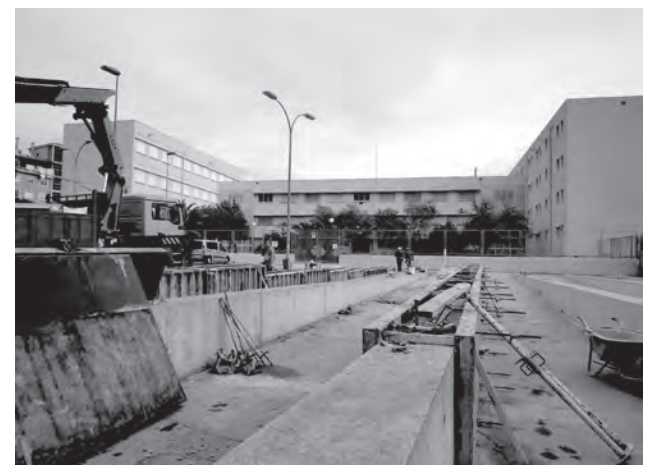
Estado de las obras el martes de esta semana
