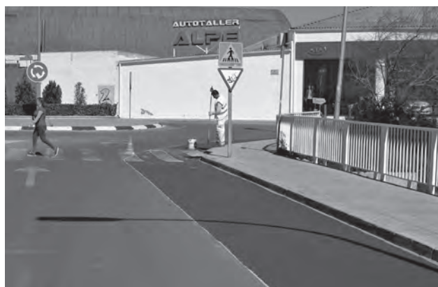
Trabajos de pintado del carril bici en la Avda. Felipe V
