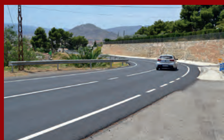
FINALIZAN LAS OBRAS EN LA CARRETERA DE CATÍ
