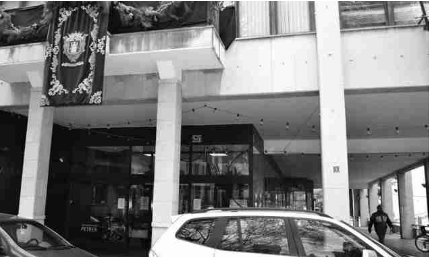
El Ayuntamiento es el edificio municipal que más actividad administrativa concentra
