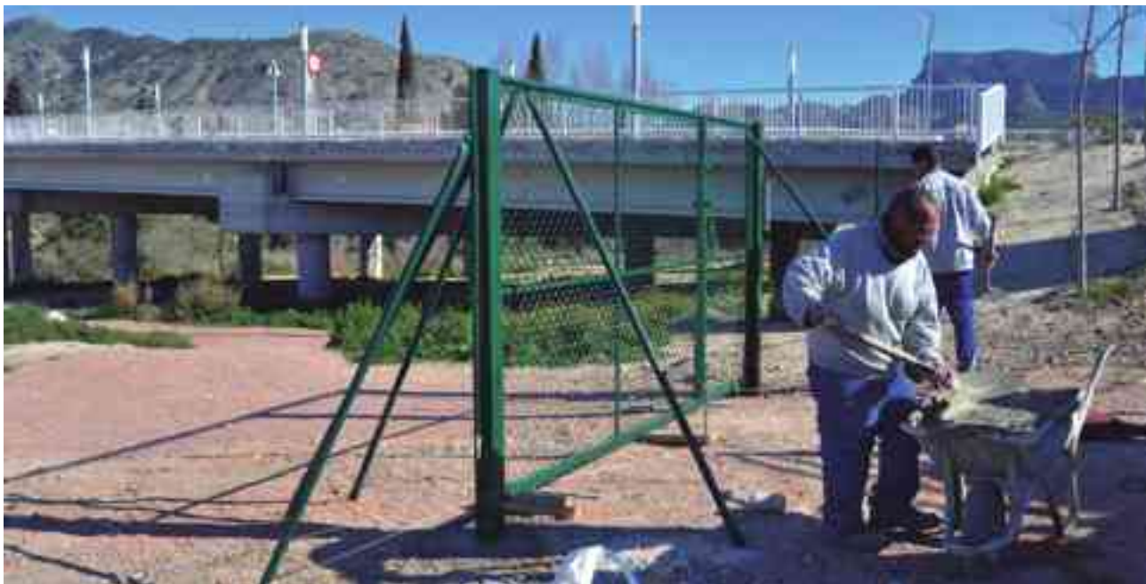
Operarios realizando labores de vallado en la zona de esparcimiento para perros
