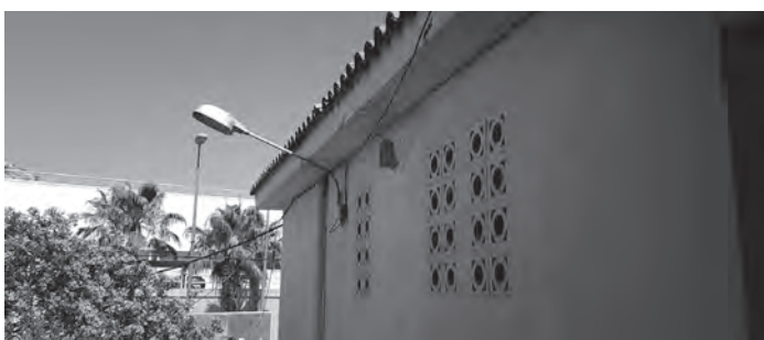
Estado de una de las fachadas de las instalaciones de Radio Petrer
