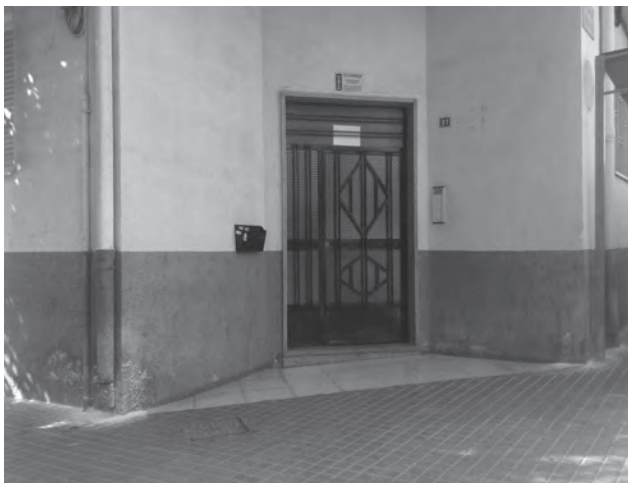
Azufre en la fachada de una vivienda
