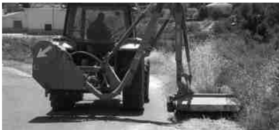
En estos momentos se están limpiando las cunetas de caminos de la partida rural de "El Forcat"
