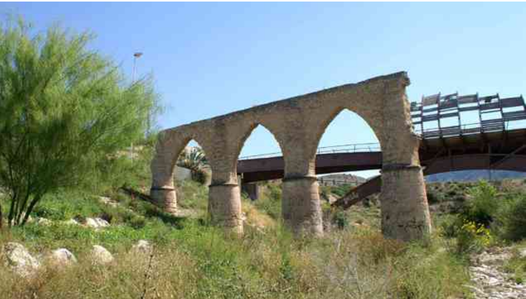
Acueducto de la "Rambla dels Molins", en el barrio de San Rafael
