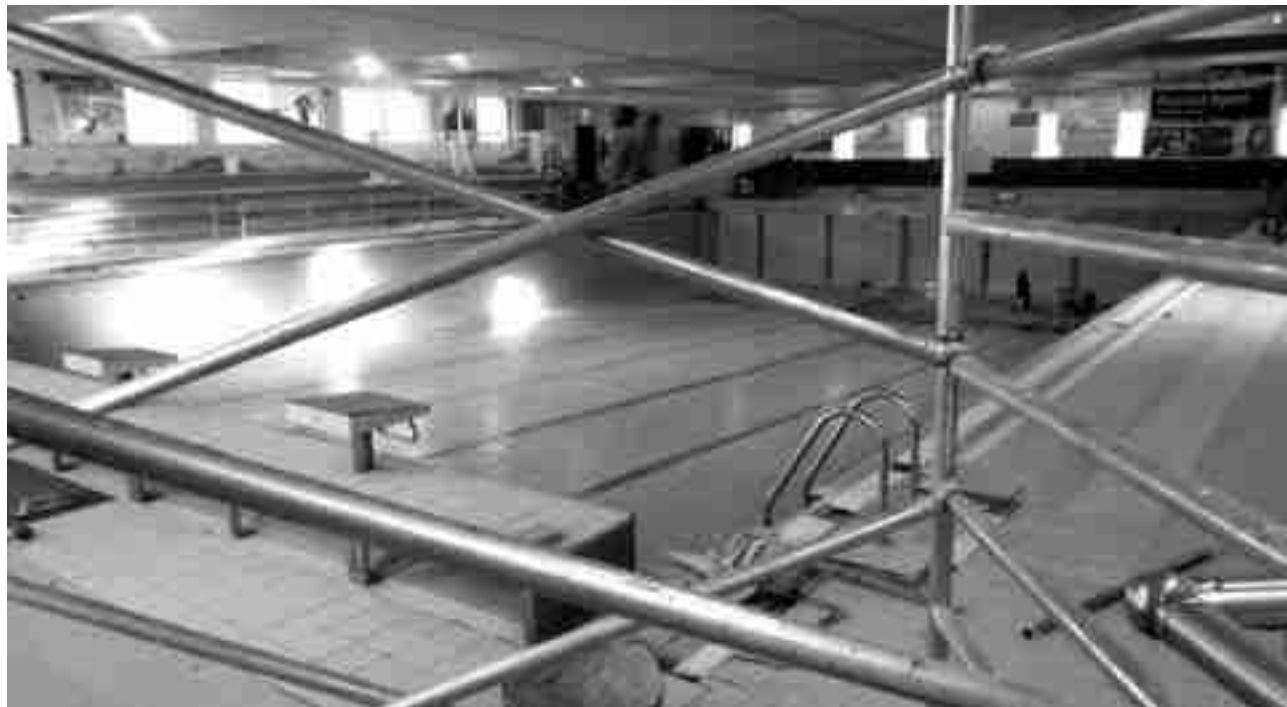
Durante estos días atrás se han llevado a cabo las obras para subsanar las fugas de agua en el vaso grande de las Piscinas Cubiertas
