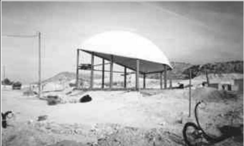
Construcción del restaurante Macdonals pionero del centro comercial Bassa El Moro.
