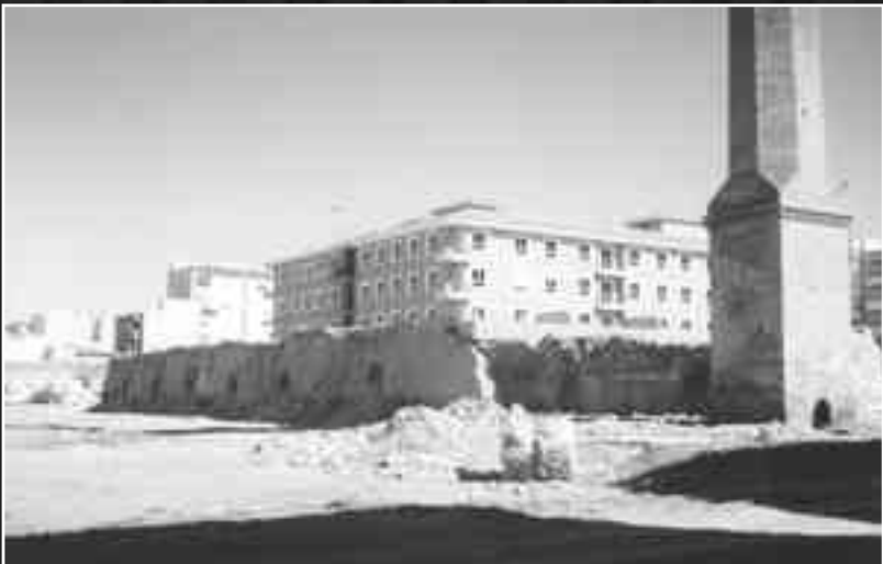
El Forn Cultural antes de su rehabilitación.
