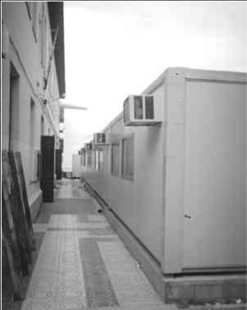
Noviembre de 1998 instalación de aulas prefabricadas tras el desalojo del colegio Primo de Rivera.
