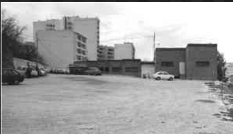
Instalaciones del primer edificio de la guardería Virgen del Remedio en la calle la Huerta, hoy demolida por culpa de la aluminosis.
