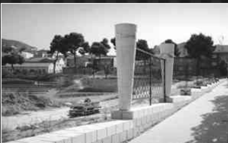
Trabajos de construcción del vallado del Parc 9 d' Octubre.
