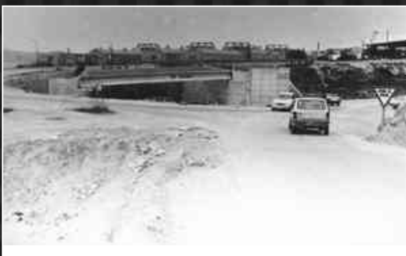
Reconversión de carretera a autovía en la zona de Salinetes.
