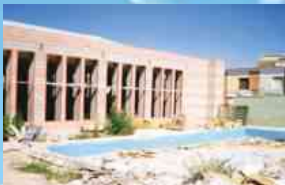
■ Construcción de la piscina cubierta
