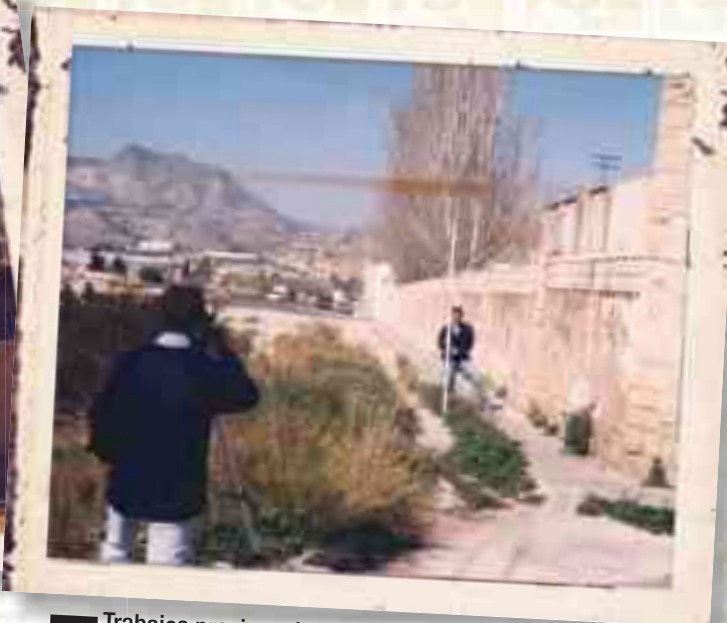
■ Trabajos previos a la construcción de la calle Castellón
