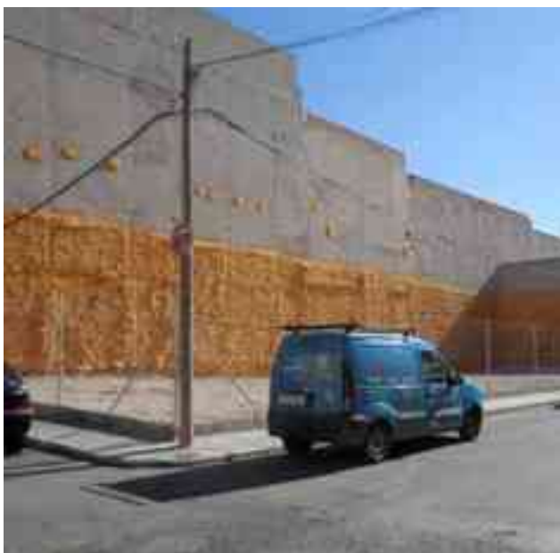
Solar en el que queda pendiente la construcción de 35 viviendas
