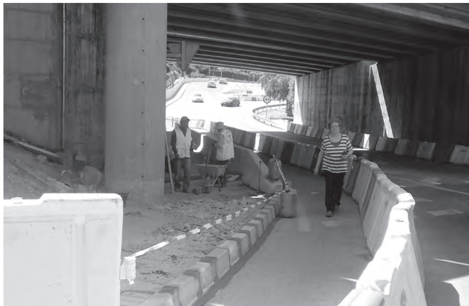
Trabajadores construyendo la barrera para garantizar la seguridad de los peatones bajo el puente de Salinetas
