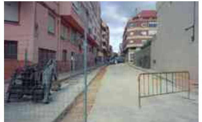
Obras de renovación de parte de la red de saneamiento, en la calle Azorín
