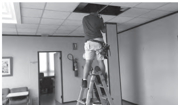
Cambio de luminarias
