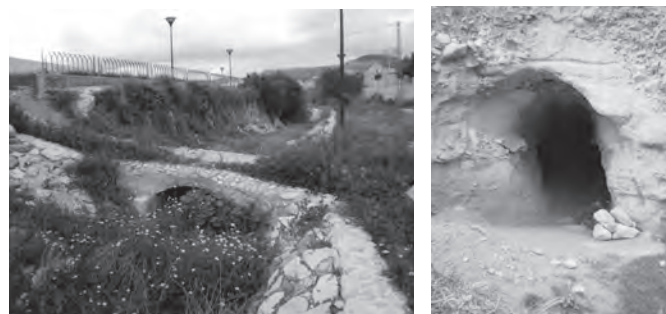
Antiguo azud de la partida de "La Canal". Detalle de la entrada a un "alcabó"
