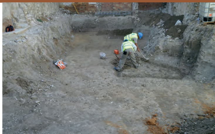
Proceso de excavación
