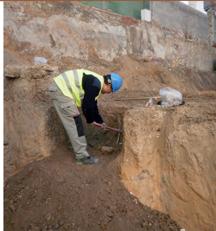
Proceso de excavación
