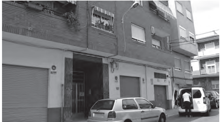
Inmueble situado en la calle Villena en el que se han producido los incidentes
