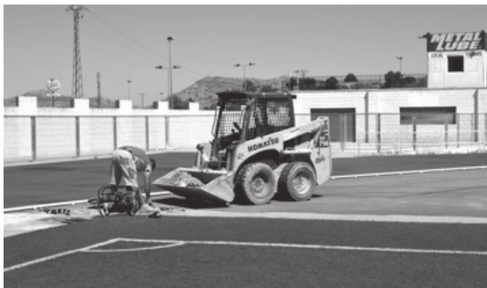
Obras de sustitución del sistema de riego que se están realizando en el campo de fútbol de césped artificial de "El Barxell"
