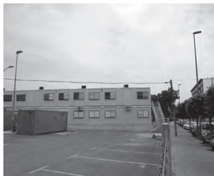
Estado actual de las aulas prefabricadas
