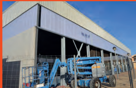
LAS OBRAS DE LA PISTA DE SAN JERÓNIMO EN SU RECTA FINAL
