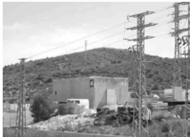
Obras de ampliación de la subestación eléctrica de Santa Bárbara
