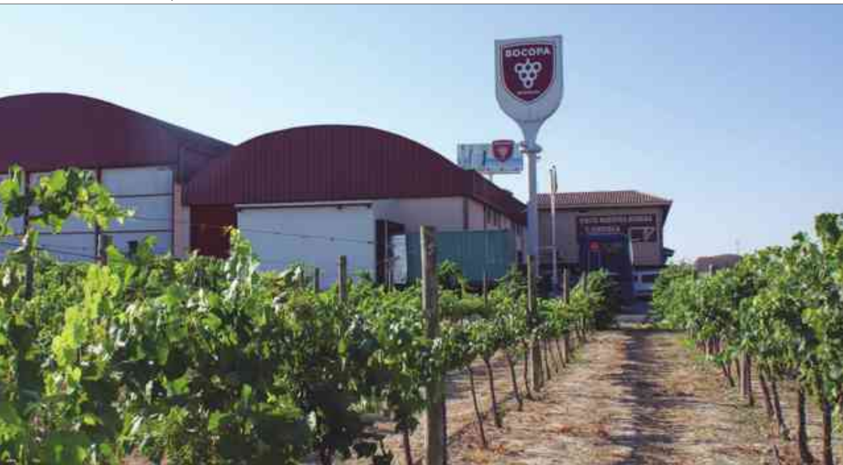
Instalaciones de BOCOPA en Les Pedreres
