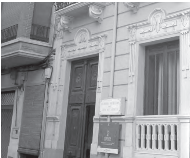
Fachada del edificio de la Mancomunidad Intermunicipal
