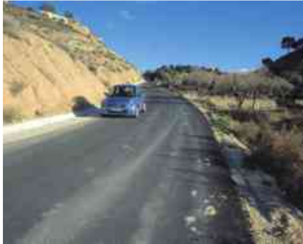
Camino de Ferrussa reasfaltado
