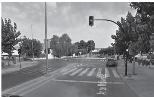
Detalle de los semáforos de la rotonda de la Avenida del Mediterráneo
