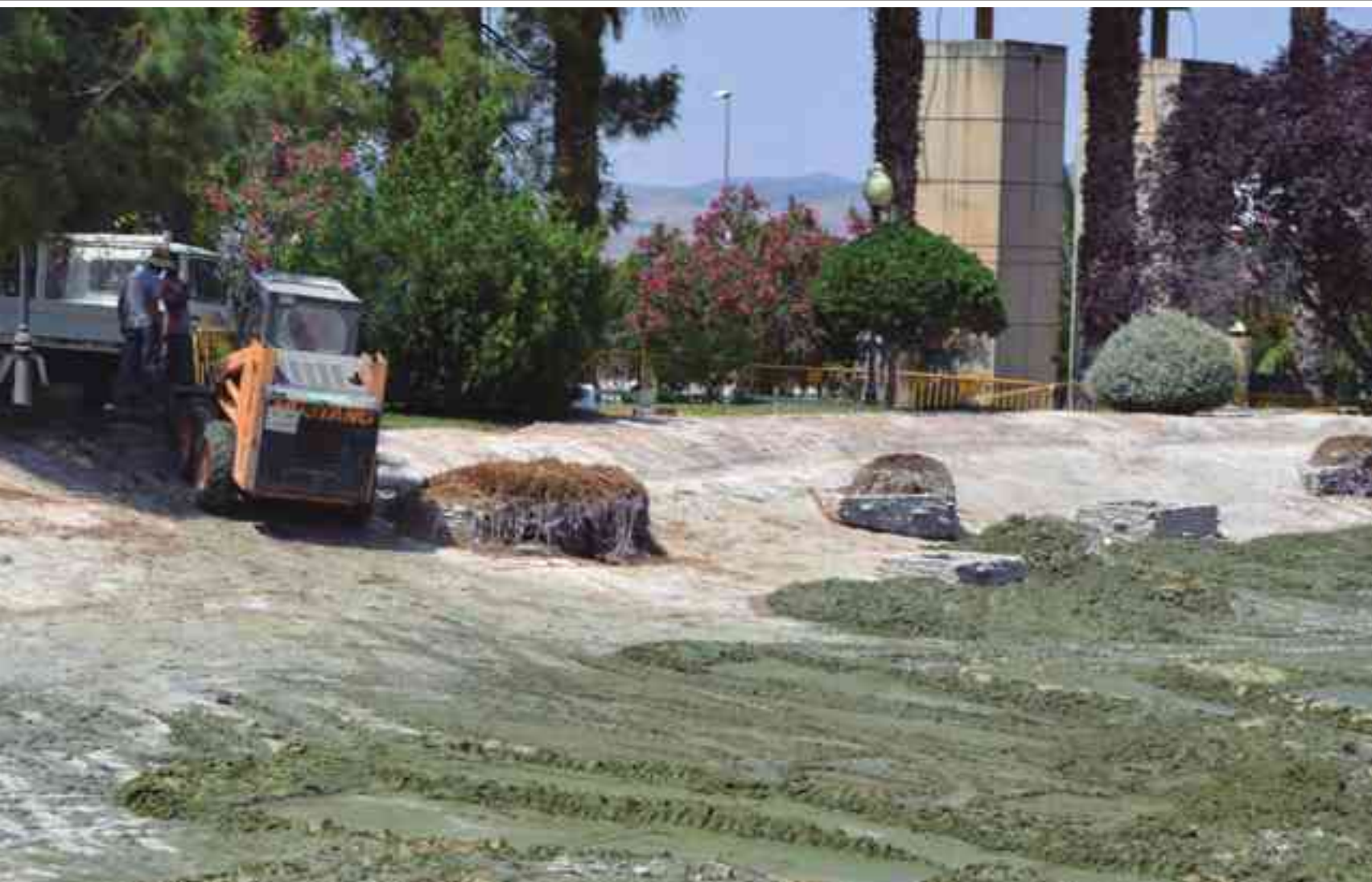
Trabajos de limpieza del lago esta semana
