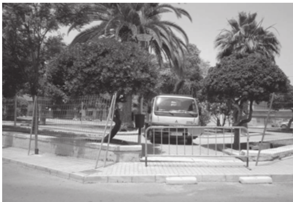
Imagen tomada antes de ejecutar las obras
