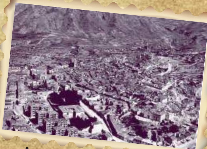
Any 1961. Vista aèria de Petrer, en la part inferior els blocs d'El Sit en plena construcció. També baix el carrer Calvari. La carretera de Catí encara no s'havia construït.
