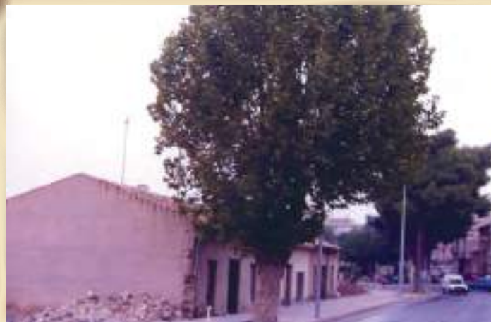
Any 1997. Comencen les obres de derrocament de les vivendes de l'Avd. Salinetas.
