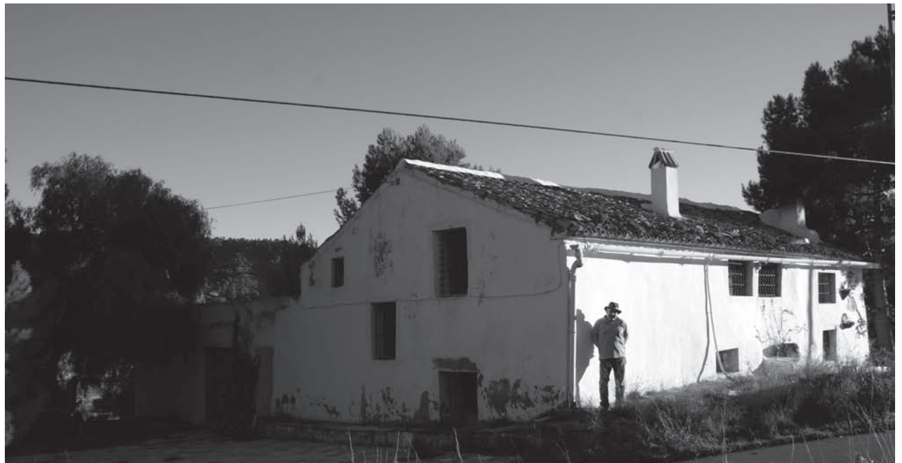
La casa de Puça que albergará el Aula de la Naturaleza
