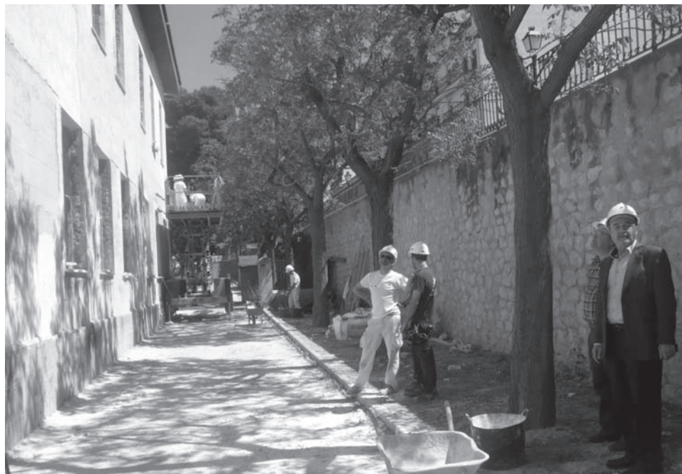
Visita del alcalde, Pascual Díaz, a las obras que todavía se ultimán en el edificio
