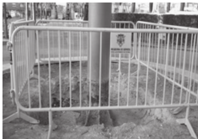
Estado actual en el que se encuentran los pilares
