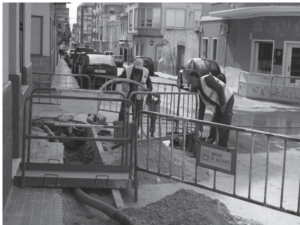
Obras de mejora en la red de agua por parte de la empresa Aguas Municipalizadas de Alicante
