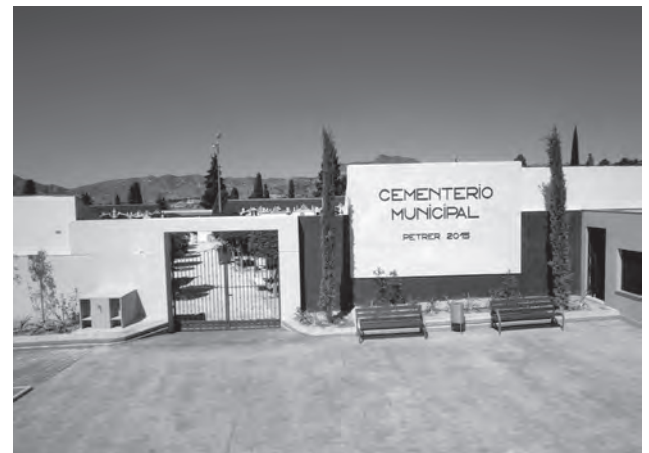
Fachada de la nueva zona de acceso del cementerio
