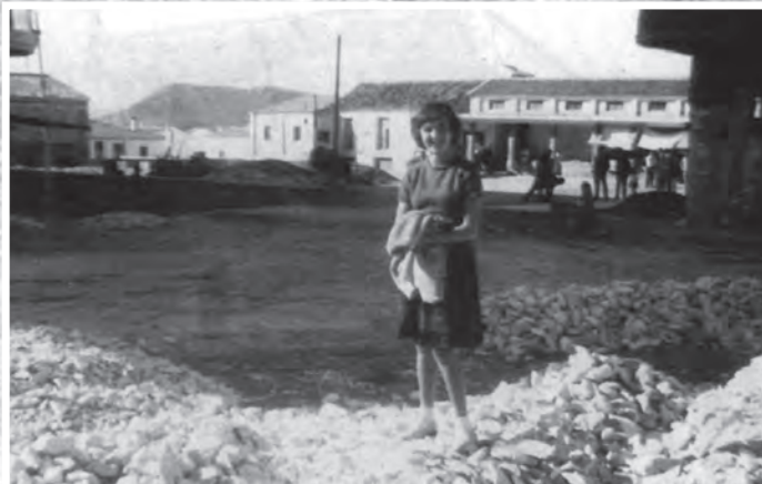
Any 1959. Vista del Derrocat en obres amb l'antic Mercat al fons.
