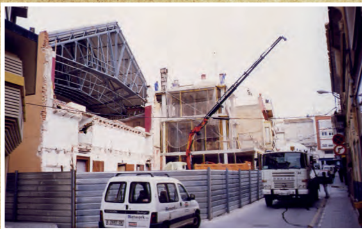
Any 1995. Obres en la fatxada principal del Teatre Municipal Cervantes.
