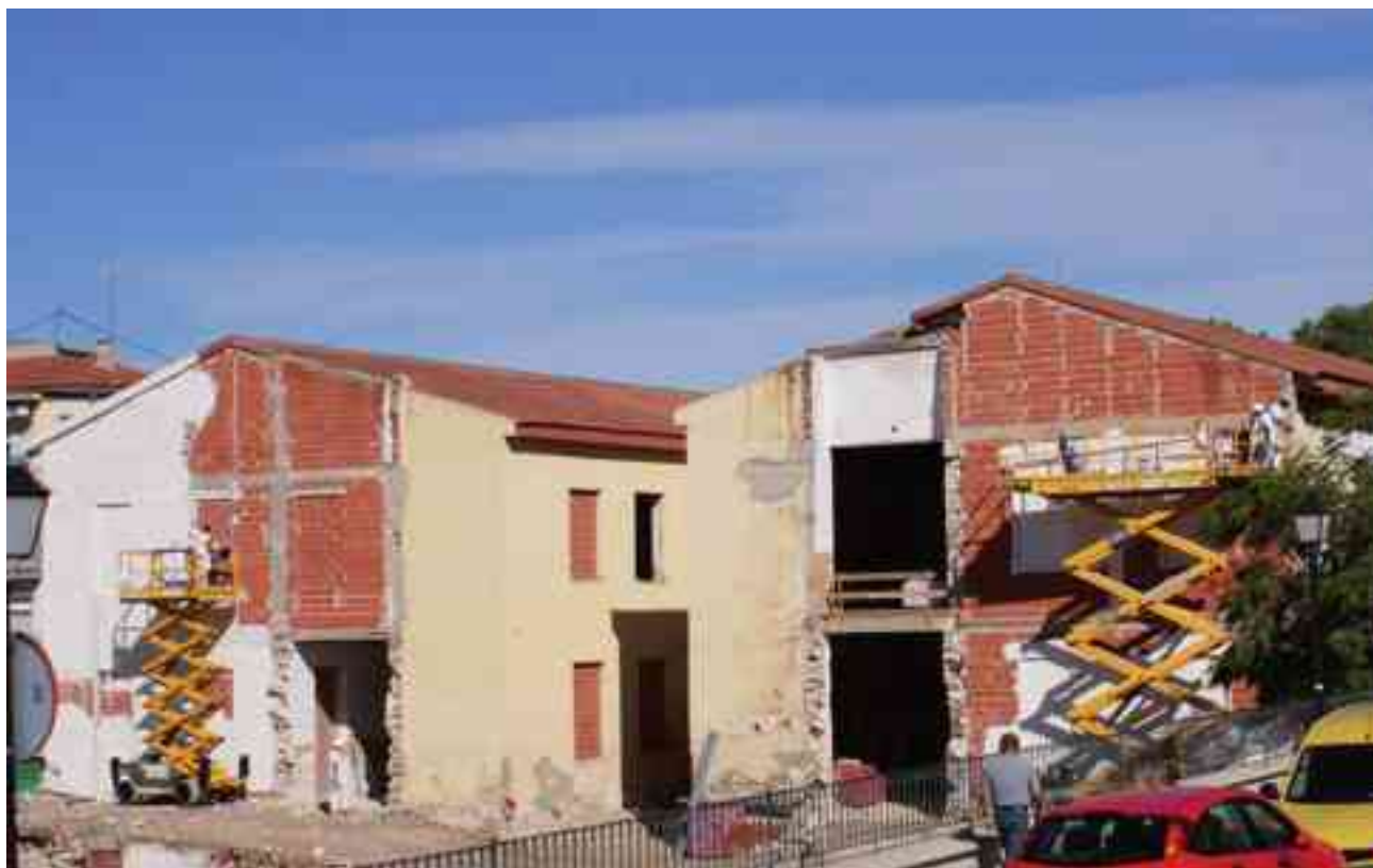
Trabajos de cerramiento de la parte posterior del edificio
