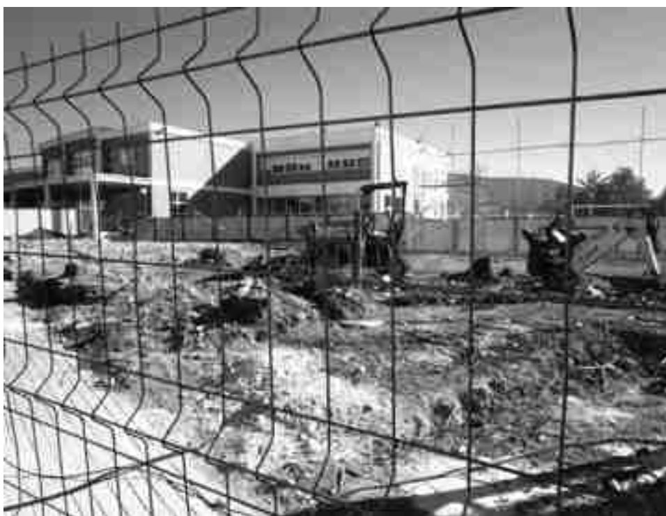
Obras de ampliación del colegio Santo Domingo Savio, en la avenida Reina Sofía
