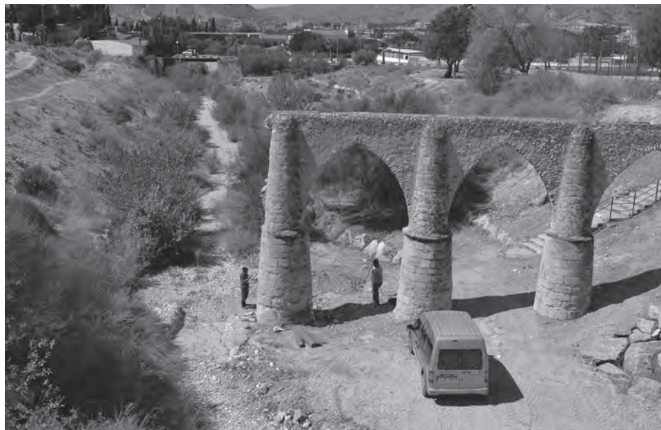
Desde el pasado lunes se están realizando obras de consolidación en el Acueducto Romano de San Rafael
