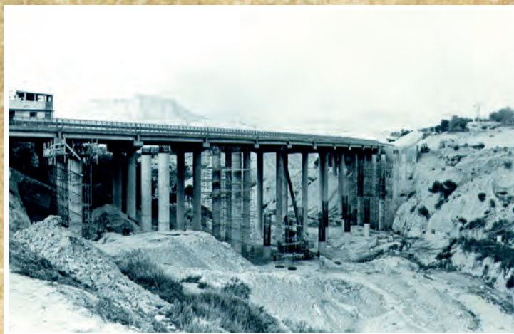
Any 1987. Obres de construcció del nou pont de l'Autovia de Madrid al seu pas per la rambla de Puça.
